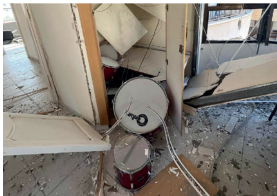
Förstörda fönster, förstörda väggar, förstörda instrument – Ajyal måste försöka börja om från början.
